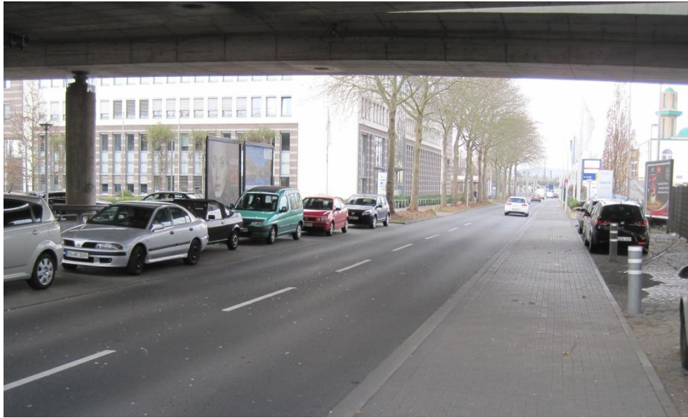
Abbildung 3.12 Brühler Straße – Unterführung der A 565
