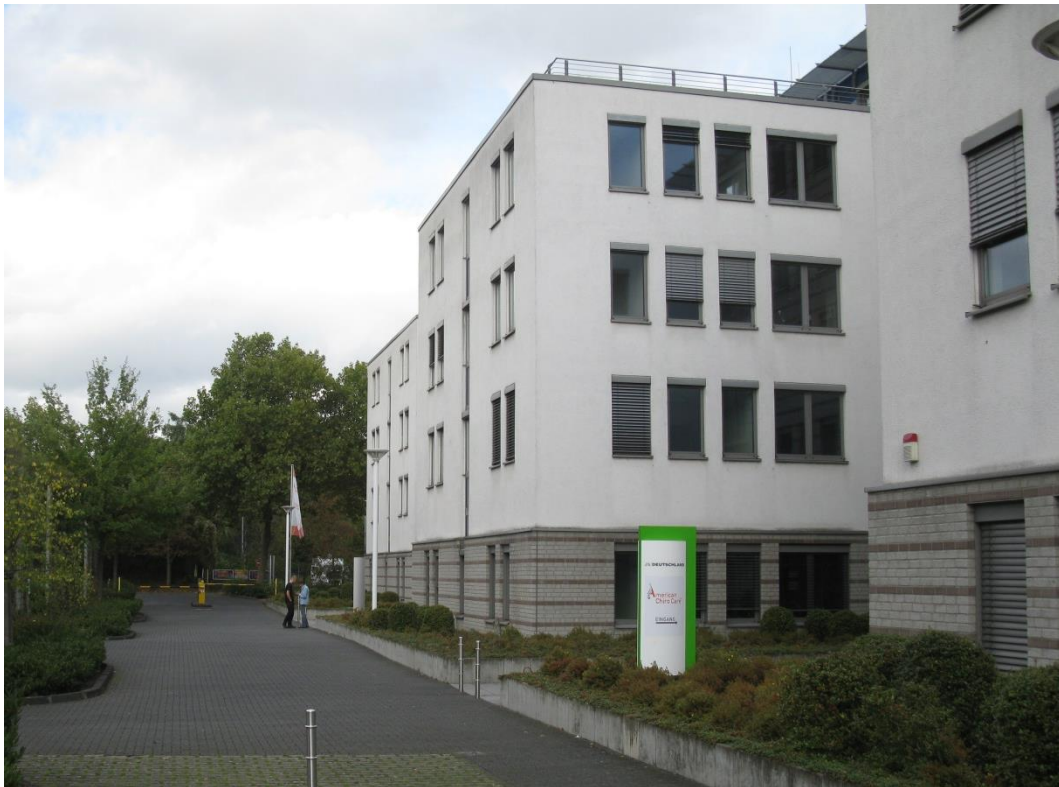
Abbildung 3.53 Gebäudesubstanz Bürogebäude Brühler Str. 7
