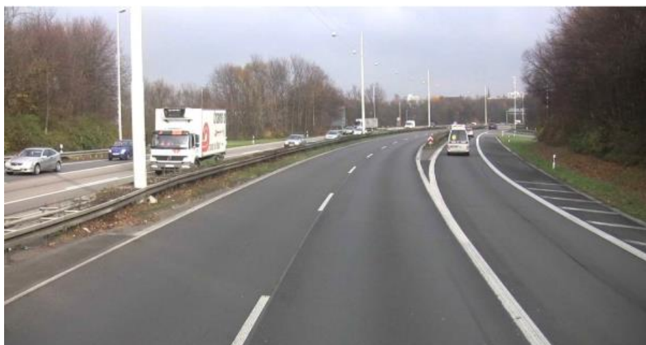
Abbildung 3.46 Anschlussbereich AK BN-Nord (Blickrichtung Norden)
