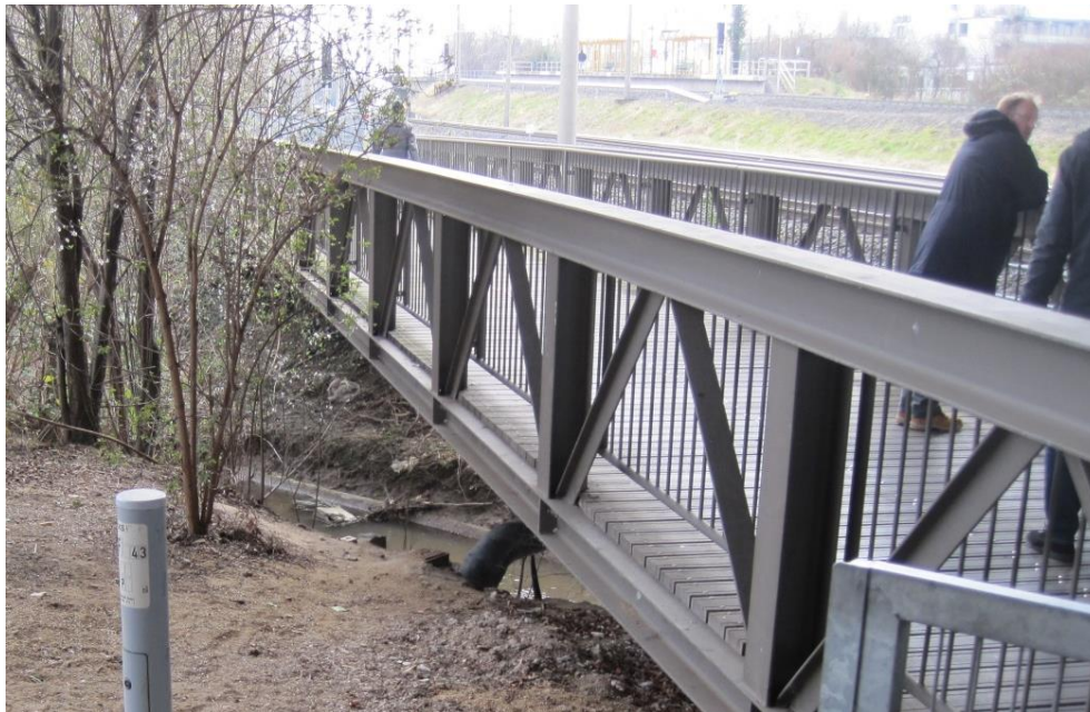
Abbildung 3.14 Geh- und Radwegbrücke Rheindorfer Bach
