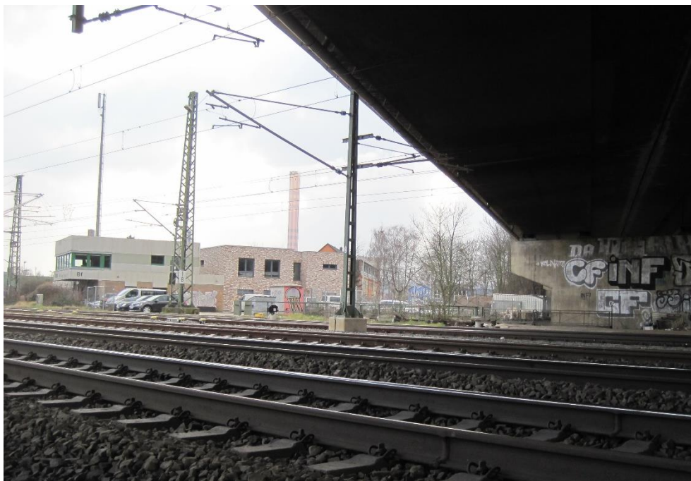
Abbildung 3.5 Gleisanlagen der DB und Stellwerk Bonn Bf
