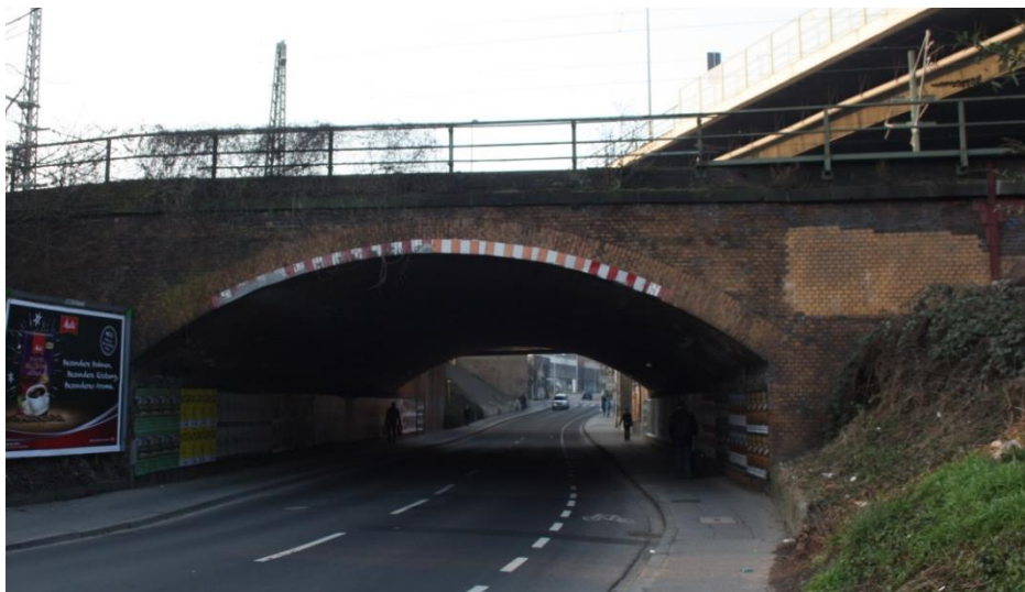
Abbildung 3.10 Straße Am Propsthof – Mauerwerksbogen Unterführung Gleisbereich
