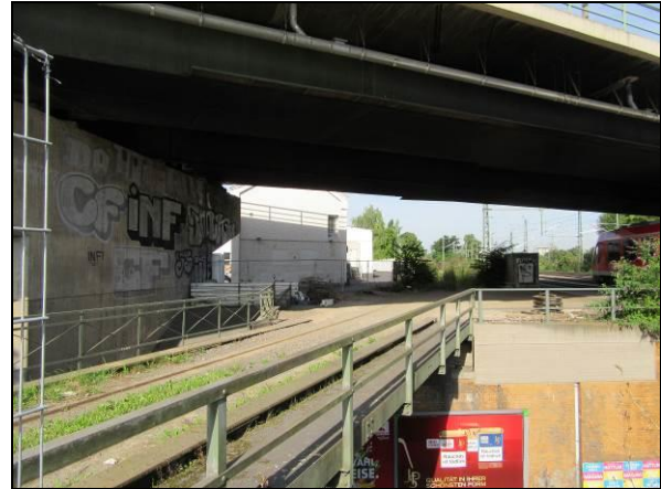
Querung DB-Gleisanlagen (Blickrichtung Nordwesten)
