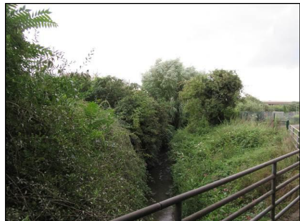
Bach mit vertiefter Sohle westlich BAB nahe der Kleingärten (Blickrichtung Westen)
