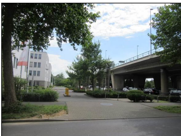
Ostseite südlich Brühler Straße (Blickrichtung Süden)
