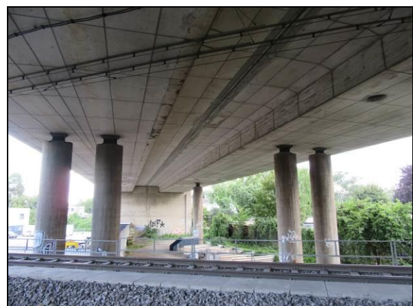
Querung Stadtbahn (Blickrichtung Süden)
