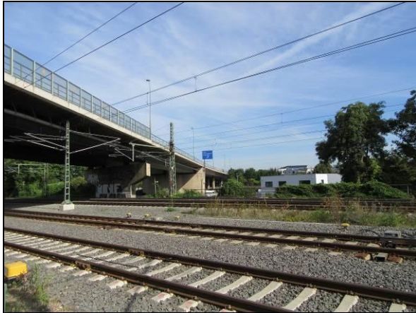
Querung DB-Gleisanlagen (Blickrichtung Norden)
