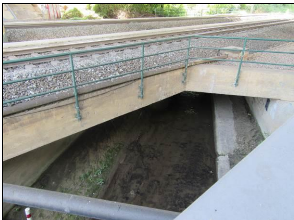
Bach in Betonschale unterhalb Tausendfüßler (Blickrichtung Westen)
